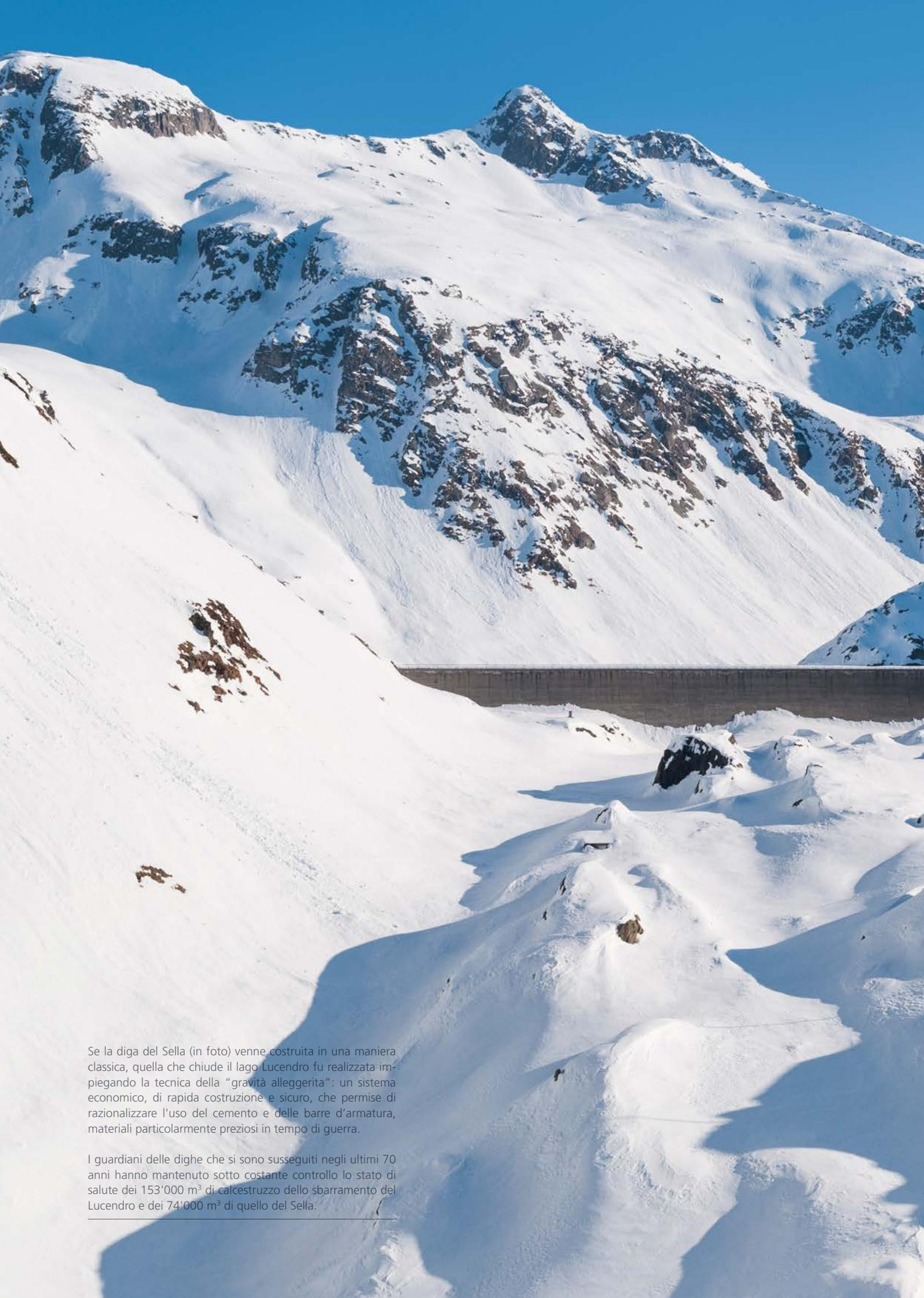
Se la diga del Sella (in foto) venne costruita in una maniera classica, quella che chiude il lago Lucendro fu realizzata impiegando la tecnica della "gravità alleggerita": un sistema economico, di rapida costruzione e sicuro, che permise di razionalizzare l'uso del cemento e delle barre d'armatura, materiali particolarmente preziosi in tempo di guerra.
