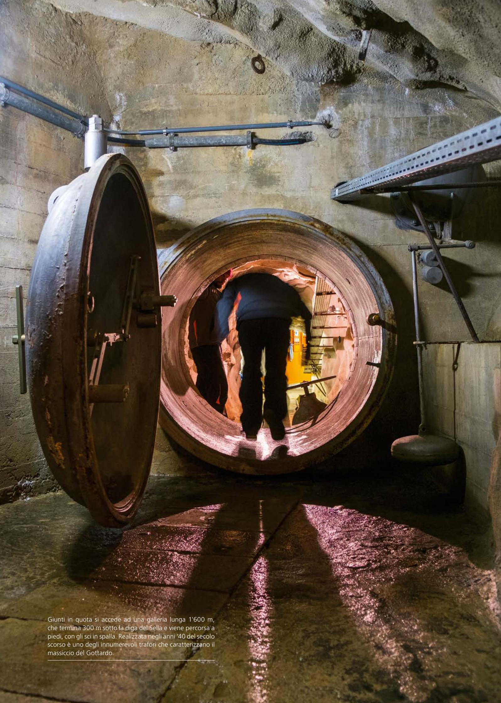
Giunti in quota si accede ad una galleria lunga 1'600 m, che termina 300 m sotto la diga del Sella e viene percorsa a piedi, con gli sci in spalla. Realizzata negli anni '40 del secolo scorso è uno degli innumerevoli trafori che caratterizzano il massiccio del Gottardo.
