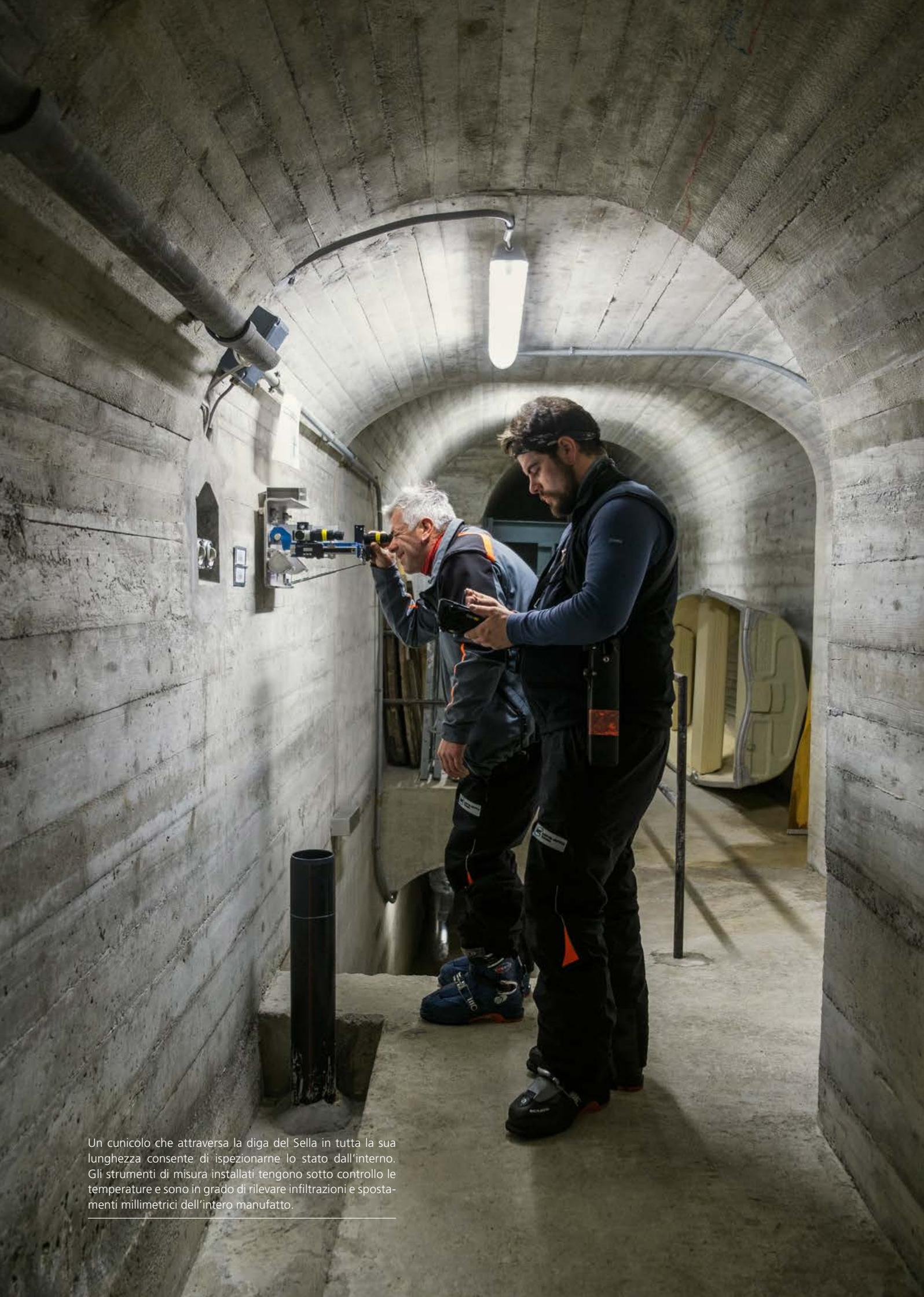
Un cunicolo che attraversa la diga del Sella in tutta la sua lunghezza consente di ispezionarne lo stato dall'interno. Gli strumenti di misura installati tengono sotto controllo le temperature e sono in grado di rilevare infiltrazioni e spostamenti millimetrici dell'intero manufatto.
